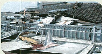
田迎西校区内被災状況
